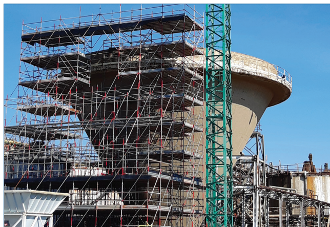
Fig. 2 - Le attività di bonifica di un impianto per la produzione di acido fosforico. In evidenza, il reattore per la lisciviazione della fluoro-apatite
